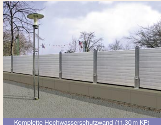
Komplette Hochwasserschutzwand (11,30m KP)
