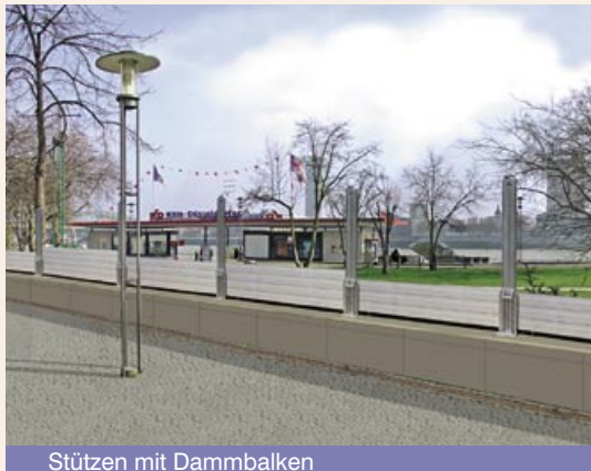
Stützen mit Dammbalken
