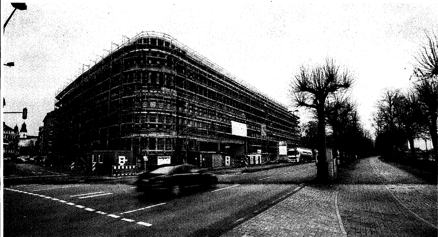
Rund 40 Millionen Euro beträgt das Investitionsvolumen des Axa-Gebäudes, das im Sommer 2008 fertiggestellt sein soll.
