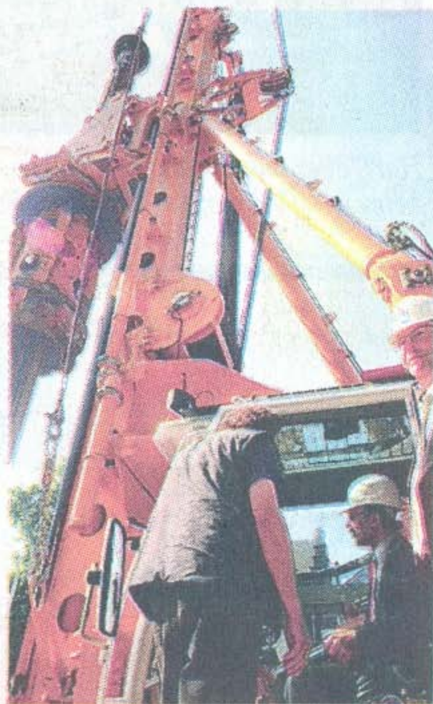
Das Bohrpfahlgerät beim Einsatz am Rhein
