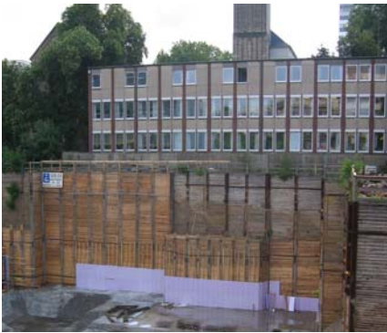
Die Baugrube der bis zu 14,00 m unter Gelände liegenden Gründung wurde mit dreifach verankerten Trägern und an der Rampe mit drei verankerten Verbaustaffeln ausgeführt.
