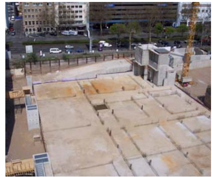
Die Decke der Tiefgarage, 5,50 unter Gelände, als Gründungsebene des Kulturzentrums mit 3 Fluchttreppenhäusern, 2 Zuluftbauwerken und dem Haupttreppenhaus
