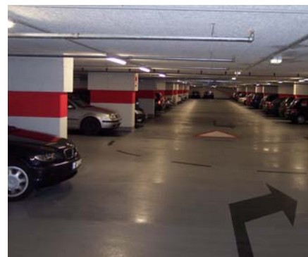
Trotz der komplizierten Lastumleitung konnte ein Stützenraster realisiert werden, welches Komfortstellplätze und benutzerfreundlichen Fahrstraßen ermöglichte.
