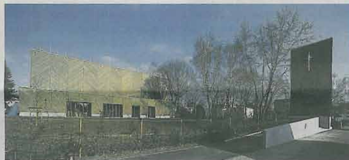
Rund ein Jahr dauerten die Bauarbeiten an der Bonhoefferstraße, nun sind der Kirchenbau (l.) und der frei stehende Glockenturm (r.) fertig.
