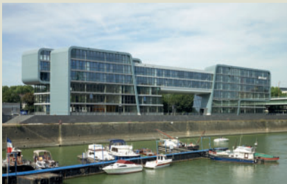
RheinartOffice, Köln. Baustatische Prüfung. Architektur: Freigeber Architekten mit Architekt Stephan Schütt. Foto: Oppermann. Bauherr: ArtOffice.
