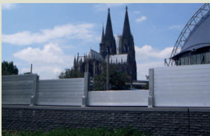
Hochwasserschutz im Bereich der Kölner Altstadt. Objekt- und Tragwerksplanung, Bauleitung und Bauoberleitung. Bauherr: Stadtentwässerungsbetriebe Köln AöR.
